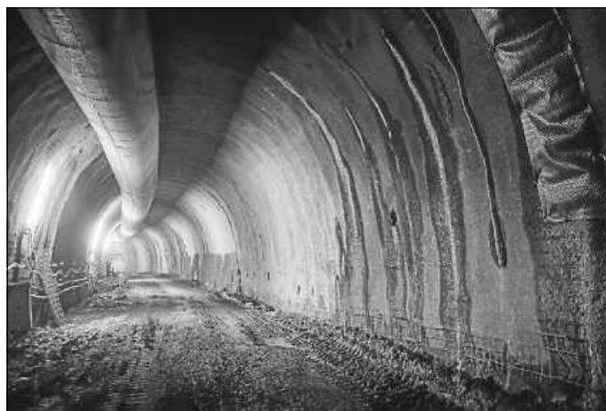
Der Neubautunnel in Ostelsheim ist 498 Meter lang.
