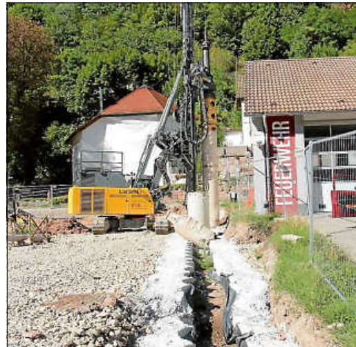
Verbau zur Böschungssicherung für das Projekt „Seniorenwohnanlage Bad Teinach“
