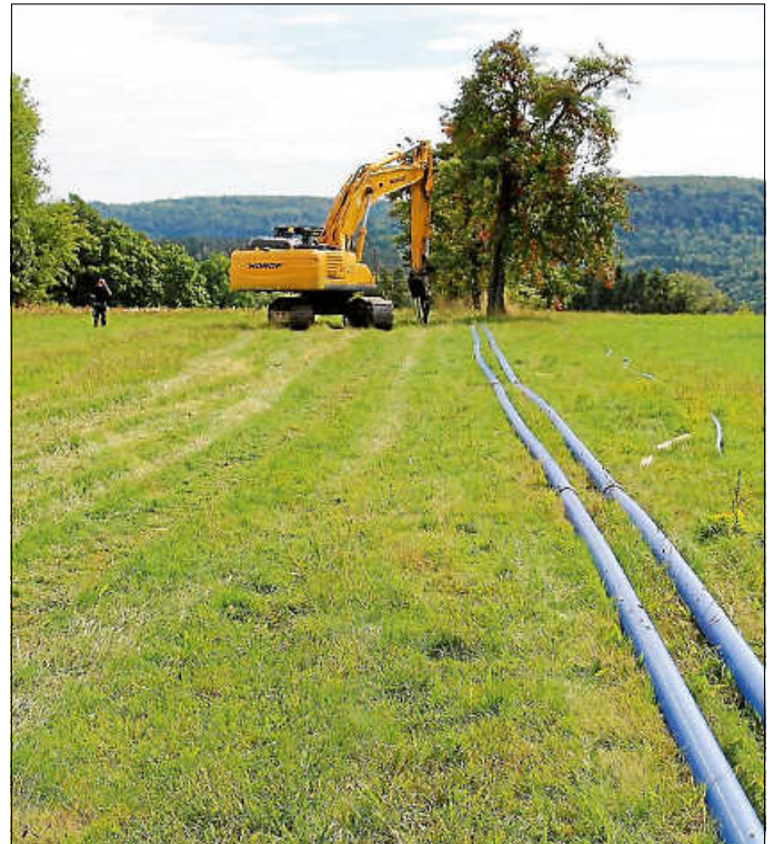
Erneuerung der Wasserleitung zwischen Lützenhardt und Kentheim
