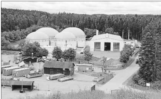
Die neue Bioabfallvergärungsanlage in Neubulach-Oberhaugstett läuft nun richtig an.
