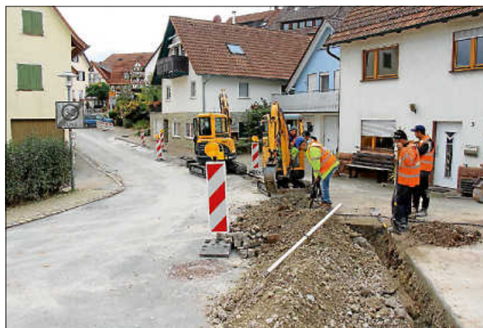
Zuführung des Glasfaserkabels in der Schulstraße.
