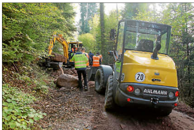
Verlegung des Glasfaserkabels im Wald zwischen der Landesstraße und Zavelstein
