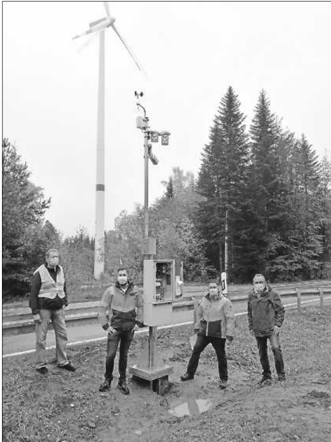
Bei der Glättemeldeanlage beim Windpark in Simmersfeld an der B294: v.l. Peter Ellerbrock (Fa. Boschung), Manuel Stengele (stellv. Straßenmeister), Michael Götz (Hauptstraßenmeister) und Gerhard Schechinger (stellv. Leiter Abteilung Straßenbau im Landratsamt Calw) Foto: Landratsamt Calw
